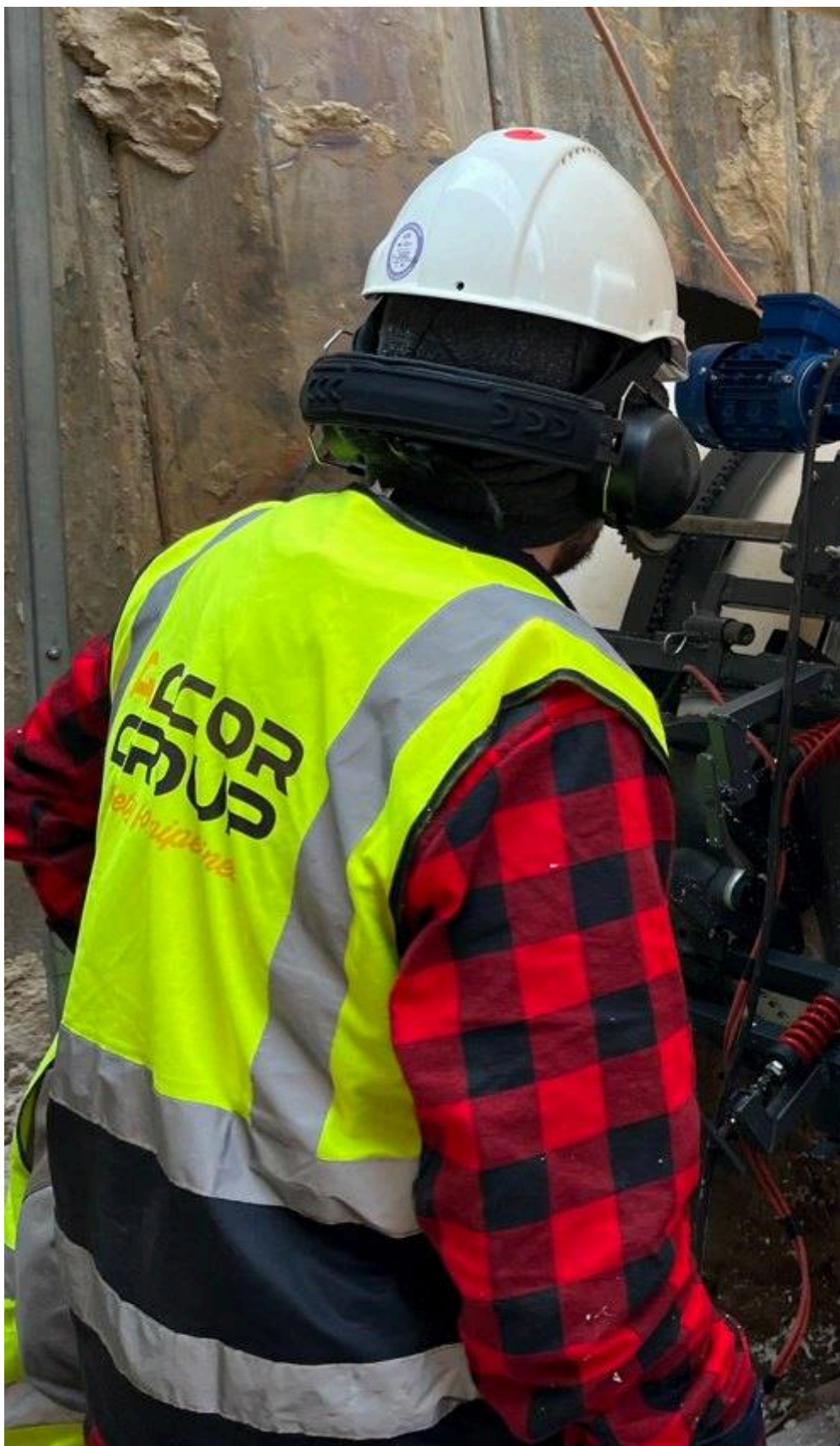
Zabezpieczenie spoiny systemem SOLIDE PP (PU-PP) — budowa gazociągu DN700 (fot. z realizacji AGCOR).
