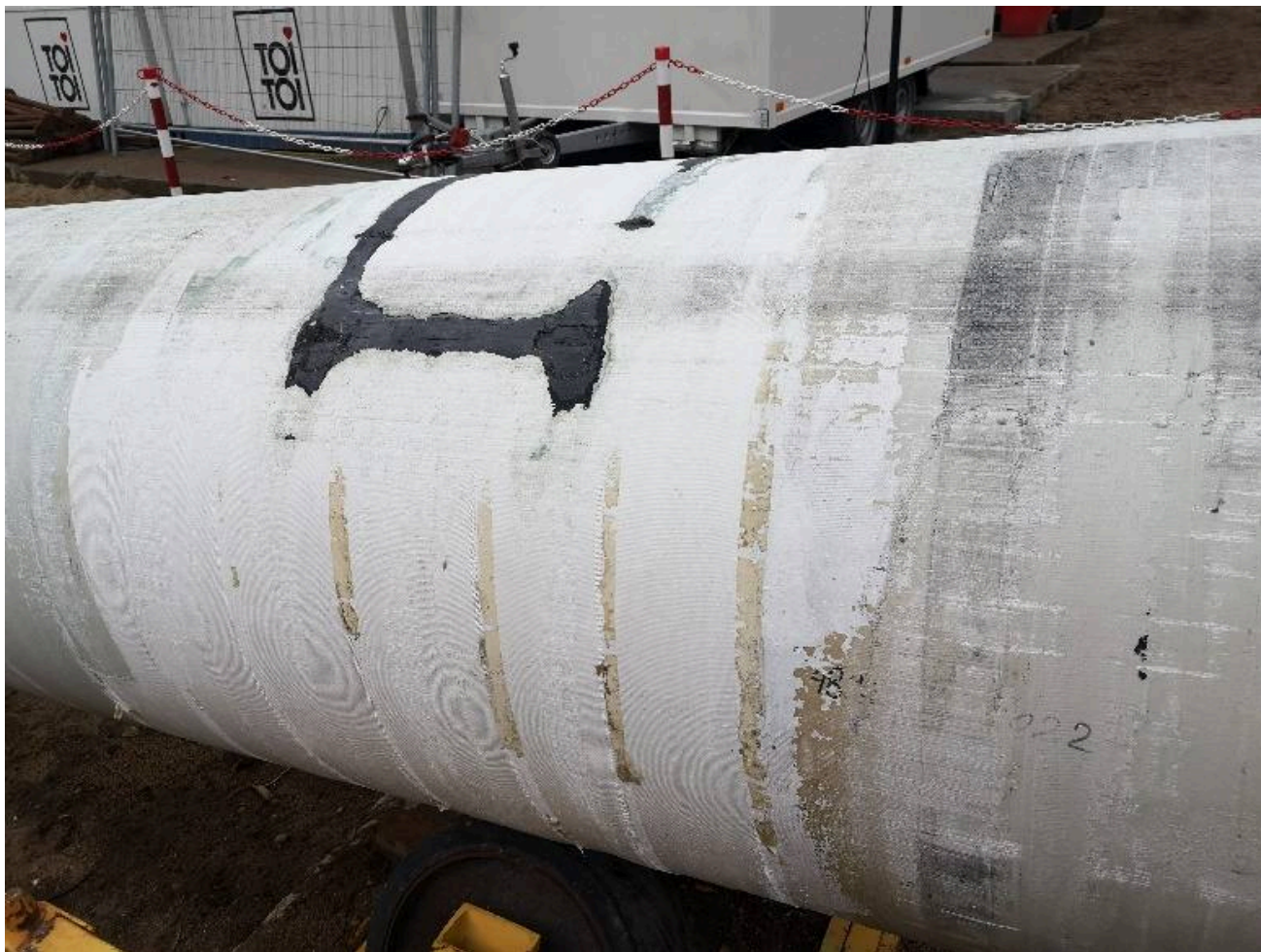
Ślady pracy izolacji na tarcu z otworem wiertniczym — przekroczenie rzeki Pełcz, Direct Pipe DN1000 (fot. z realizacji AGCOR).
