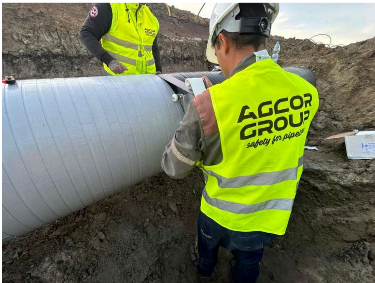
Aplikacja systemu na złączy z użyciem palnika — kontrola temperatury stali jest elementem jakości (fot. AGCOR).
